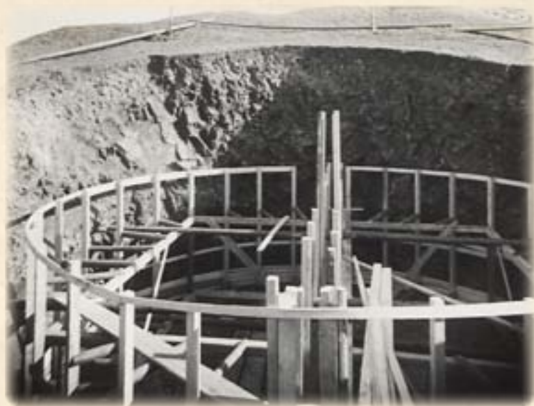
Betonování nádrže na vodu, 1931
