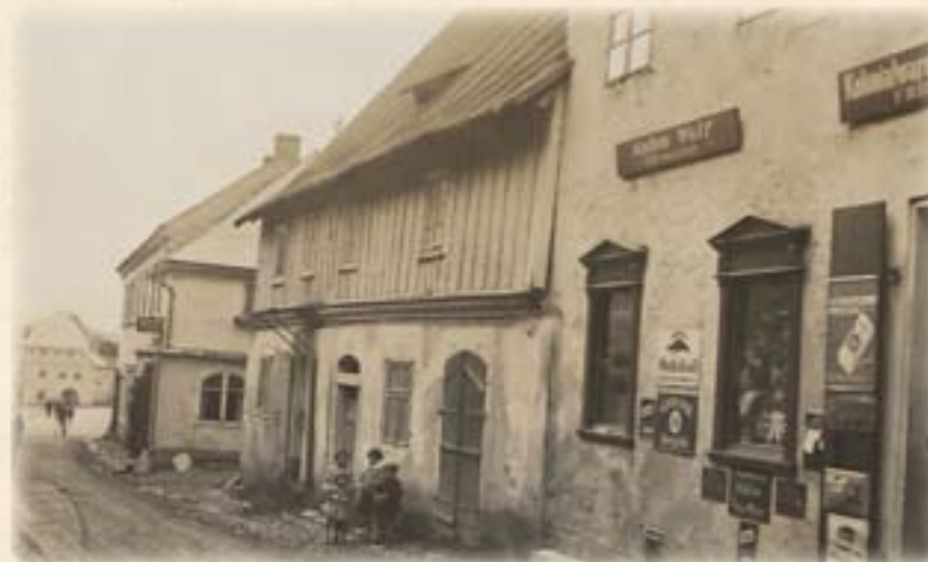
Dom č. 121 v Kostelní ulici před zbouráním, 1930
